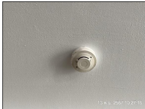
ภาพที่ 36 เครื่องตรวจจับควัน (Smoke Detector)
