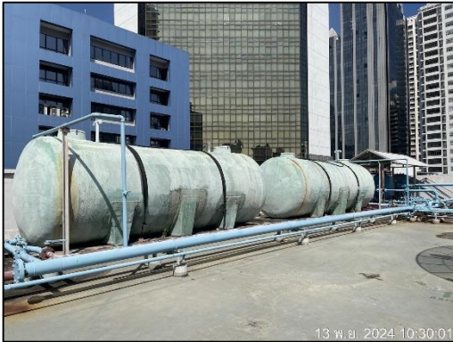
ภาพที่ 12 ถังเก็บน้ำชั้นดาดฟ้า (2 ถัง)
