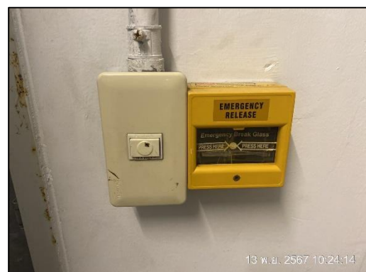
ภาพที่ 35 อุปกรณ์แจ้งเหตุฉุกเฉินแบบใช้มือดึง (Alarm Manual Station)
