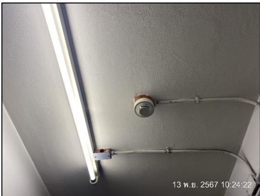
ภาพที่ 36 เครื่องตรวจจับควัน (Smoke Detector)
