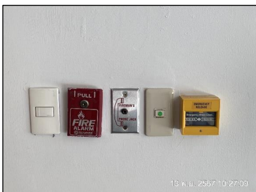
ภาพที่ 35 อุปกรณ์แจ้งเหตุฉุกเฉินแบบใช้มือดึง (Alarm Manual Station)
